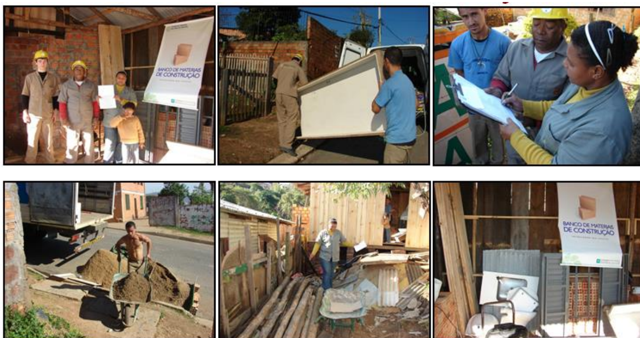
Figura 5 – Doações de materiais de Construção para pequenas reformas nas comunidades
