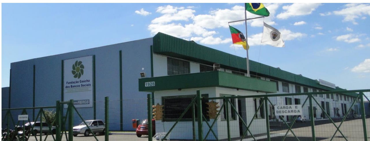
Figura 1 – Fachada da Fundação Gaúcha dos Bancos Sociais da FIERGS
