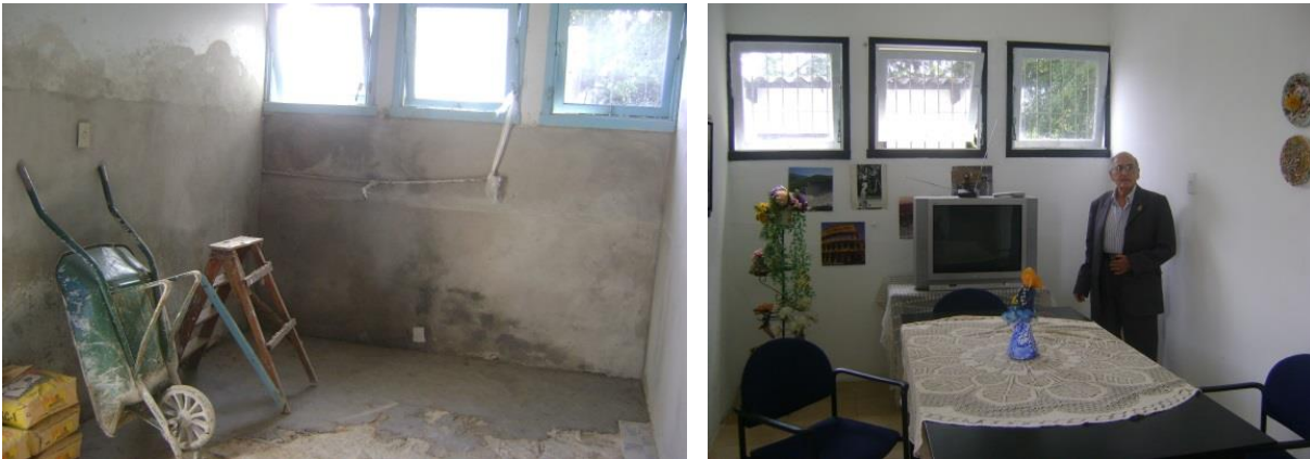
Figura 6 – Casa do Artista Riograndense (atendimento a idosos) - Reforma da sala de estar, realizada com doações do Banco de Materiais de Construção.
