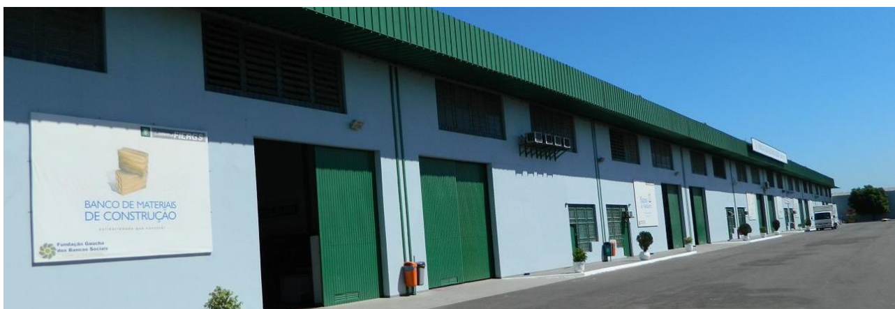
Figura 2 – Instalações do Banco de Materiais de Construção
